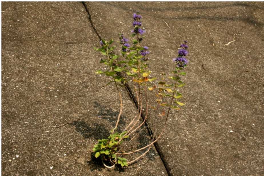
Fig. 2-6. 法面工事によるコンクリートの隙間に生育する様子
