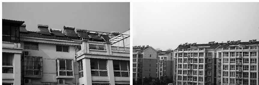
図5 洛陽市にある住宅区の屋根の様子
