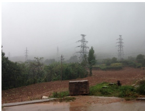
図6-3 清源風力発電所の所在地及び電力輸送設備
