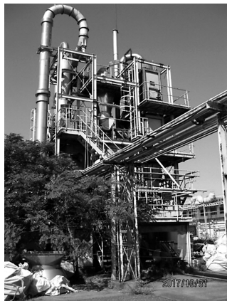
写真7 廃止された汚泥焼却施設
