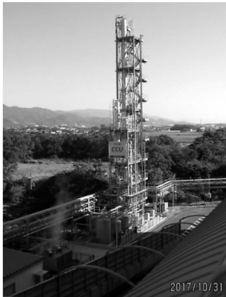
写真5 佐賀市清掃工場の二酸化炭素分離回収設備
