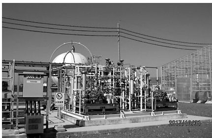
写真 12 下水道革新的技術実証事業への利用技術実証事業、二酸化炭素分離回収装置
