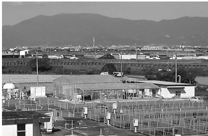
写真 10 浄化施設（手前）に隣接する藻類培養棟
