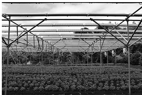
図8 単管パイプによるソーラーシェアリング設備の例②
