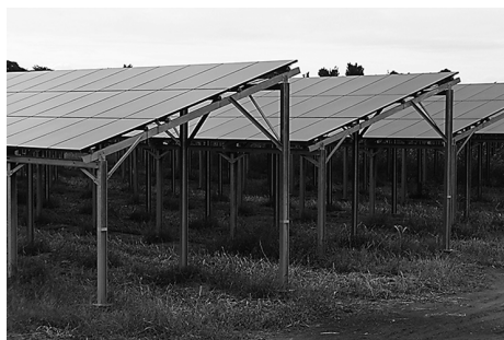
図10 足高式のソーラーシェアリング設備の例
