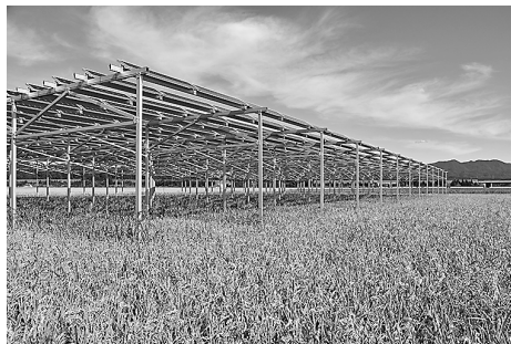
図9 水田におけるアルミ製架台を使用した藤棚式設備の例
