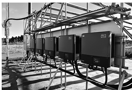
図6 海外製パワーコンディショナーの設置例
