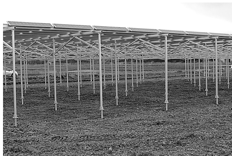
図3 下部空間を広く確保したソーラーシェアリング設備
