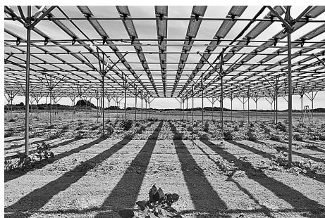
図4 スリムタイプモジュールによる発電所の例
