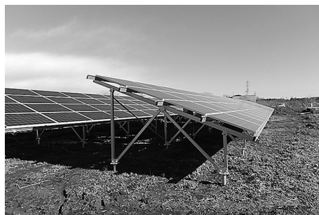
図2 一般的な野立ての太陽光発電設備
