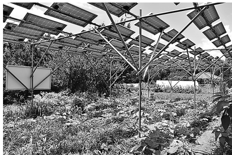
図7 単管パイプによるソーラーシェアリング設備の例①
