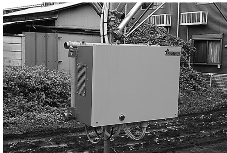
図5 国内製パワーコンディショナーの設置例 側面に吸気ファン
