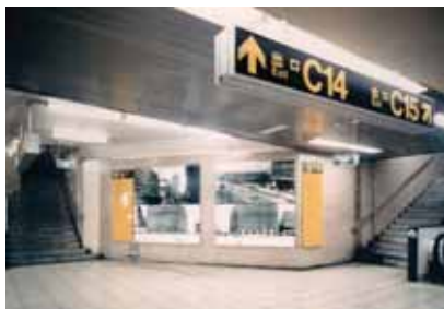
写真 1-1 1973 年竣工・千代田線大手町駅
