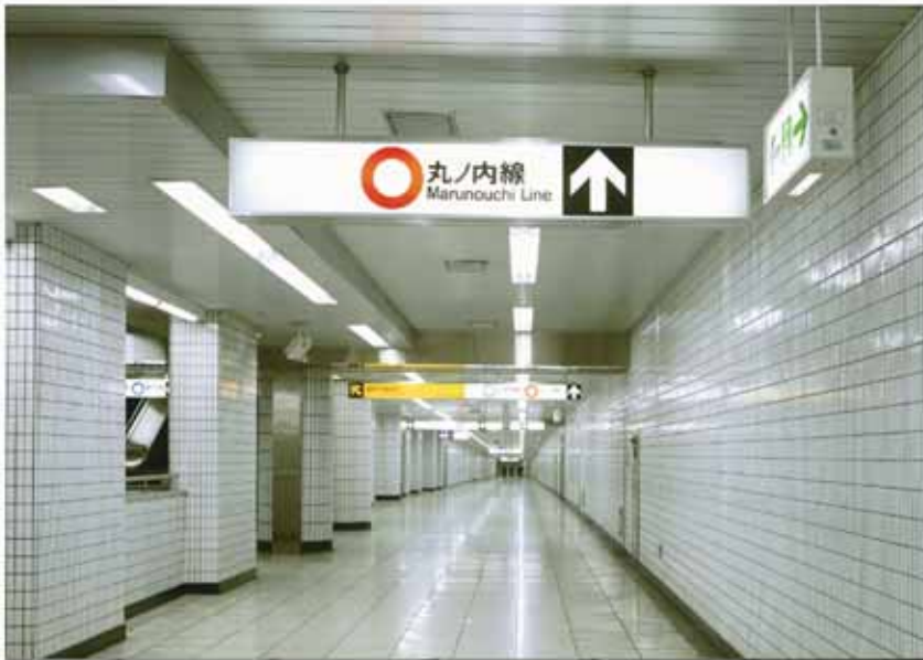
写真 6-49 1988年開業時の 大手町駅のコンコース
