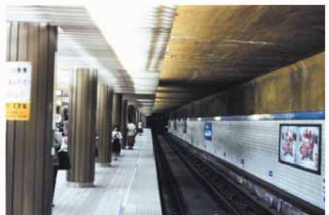
写真 7-11 ホーム対向壁のボーダーサイン
