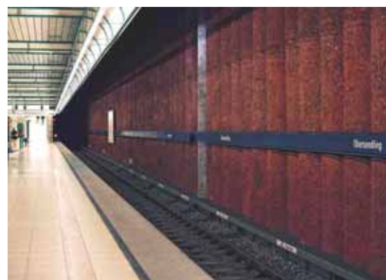
写真 11-11 土留め杭を現しに表現したミュンヘン市地下鉄(筆者撮影 1990)
