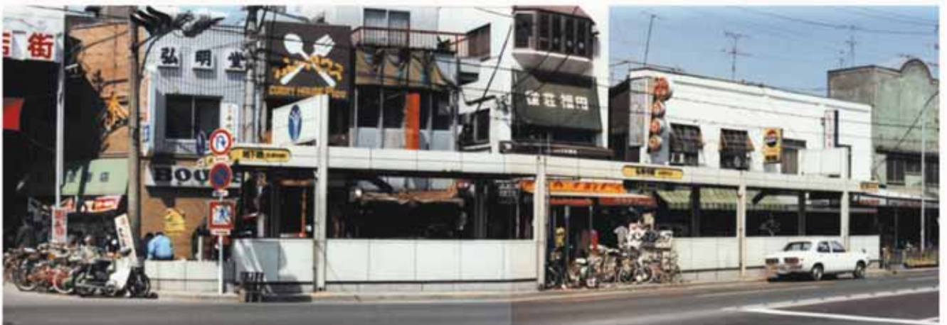
写真 7-5 出入口ゲート全景
