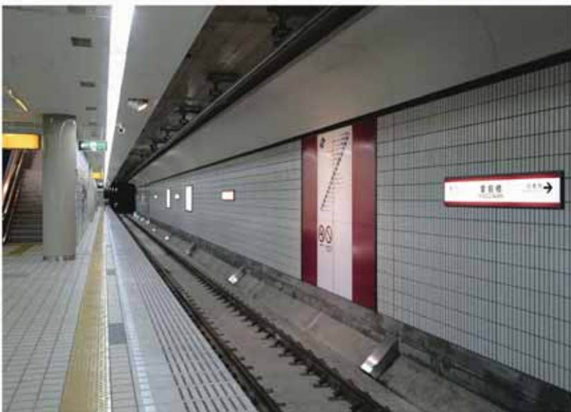
写真 7-27 愛宕橋駅ホーム縁辺部と対向壁
