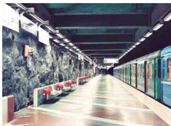
写真 11-10 岩盤の掘削跡を残す仕上げのストックホルム市地下鉄(筆者撮影 1991)
