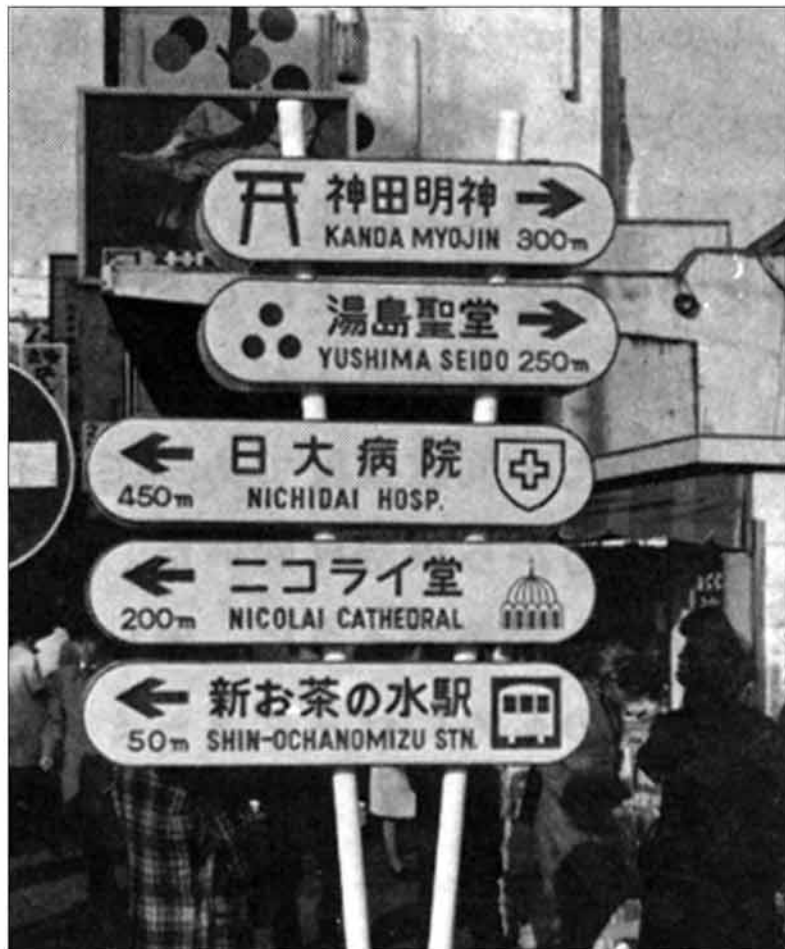
写真 4-5 1974年11月に試験設置されたシンボル入り著名地点標識 (『案内標識の設置に関する方法等の研究報告書(第三次)』) 上が後樂園付近、下が御茶ノ水駅付近。
