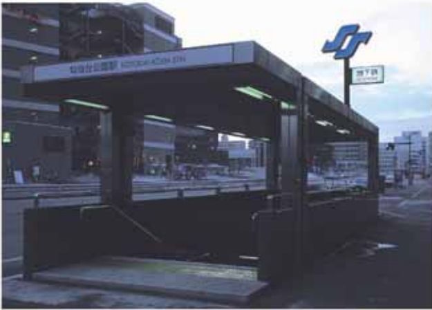
写真 7-28 標準型歩道上出入口 シンボル標・地下鉄標
