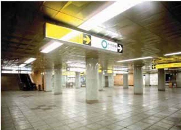
写真 6-42 1977年半蔵門線開業時の表参道駅のコンコース
