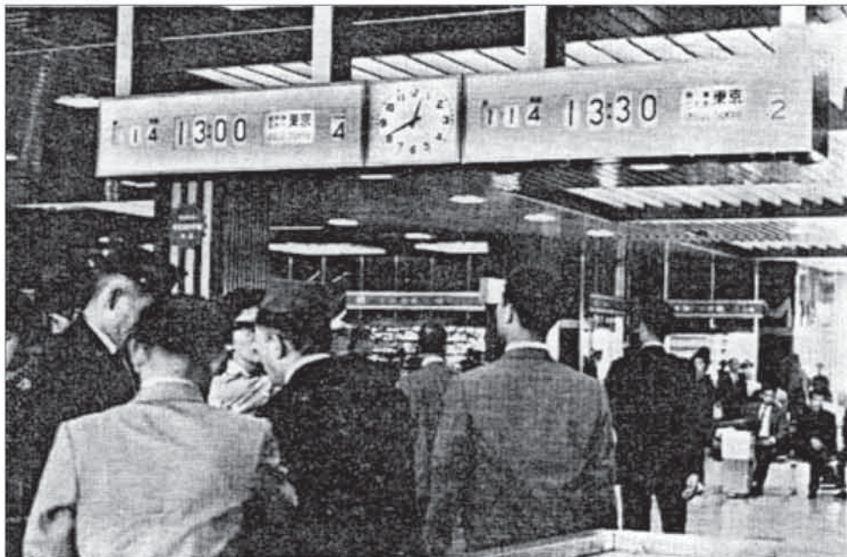
写真 3-19 発車標に組み込まれた時計 (『電力と鉄道 1965年4月号』)
