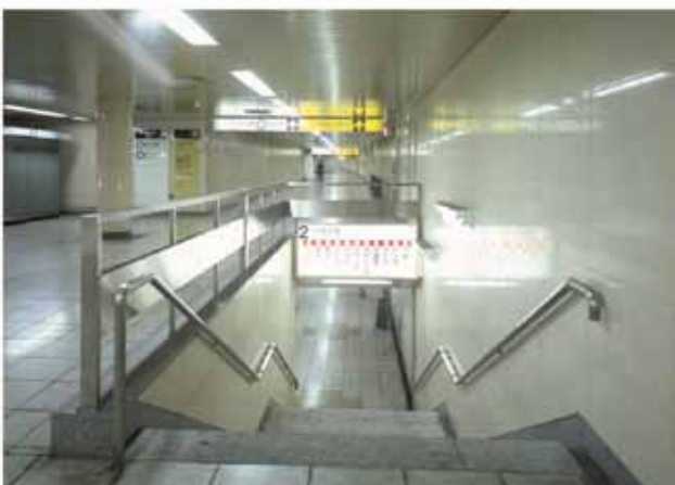
写真 6-44 1981年改修時の霞ヶ関駅のホーム階段部分
