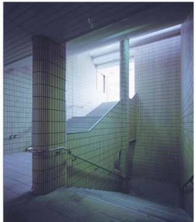
写真 7-24 愛宕橋駅建屋型出入口の広々とした内空
