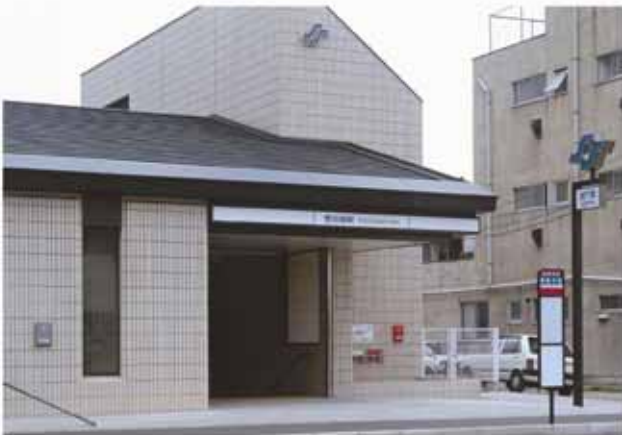
写真 7-23 愛宕橋駅建屋型出入口
