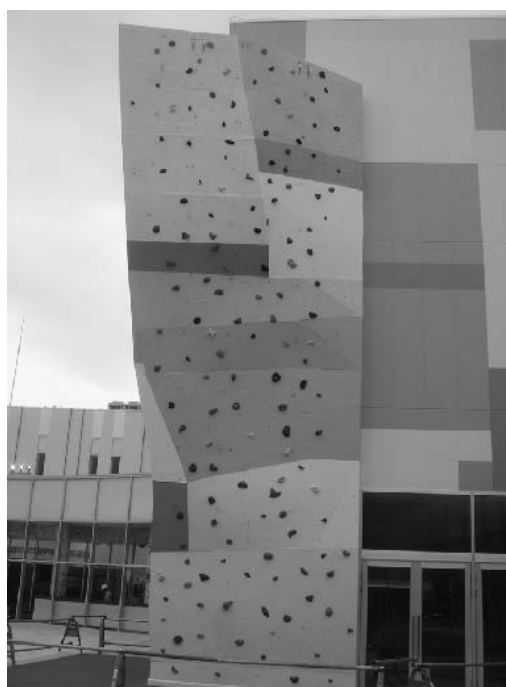
写真2 完成時のウォール
