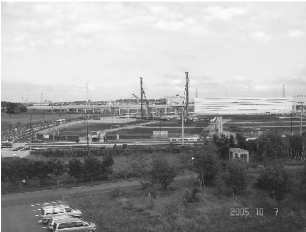
写真1 「ららぽーと柏の葉」建設工事（2005.10.7）
