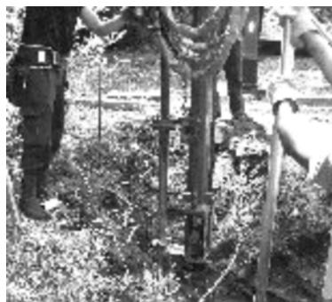
写真4-2 50φ同軸採熱管打ち込み
