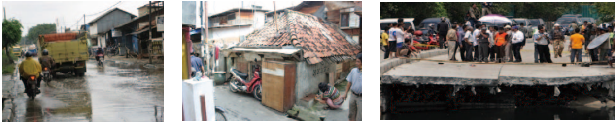
(a) Kapuk Dalam 通りの大洪水 (b) Mangga dua 地域に地盤沈下 (c) Ancol 市に崩落した高速道路
