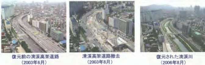
ソウル市清溪川復元区間 2003年7月1日に清溪川復元工事が始まり、2ヶ月で高架道路を撤去し、2年3ヶ月というハイスピードでの施工は韓国ならではのものである。
