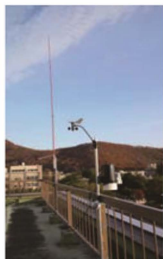
大学建物屋上(地上高約30m)に固定設置していた気象観測ステーション奥に見えるのは、基地局用のアンテナ
