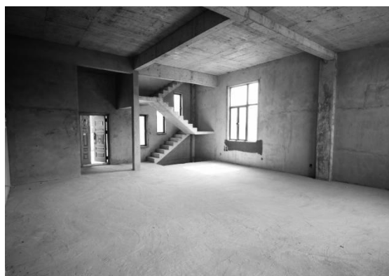
図 5-23 内装工事前のスケルトン状態（毛坯房）
