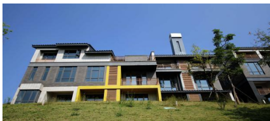
住棟 A 外側面
