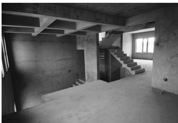
図 5-23 内装工事前のスケルトン状態（毛坯房）
