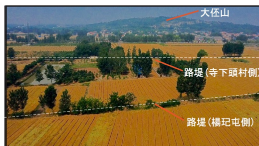
現在における路堤の様子
