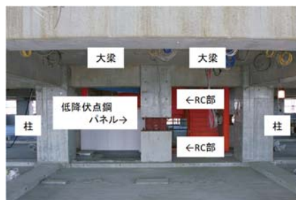
図 2.1.2 RC・S 複合間柱の例
