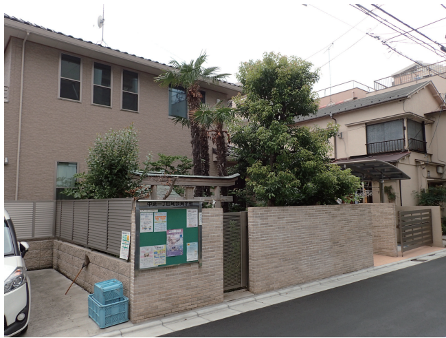
図 4-6 岡田家多田公稲荷神社の外観 (著者撮影)
