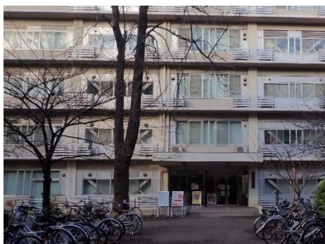
写真 2. 千葉大学総合校舎 1 号館
