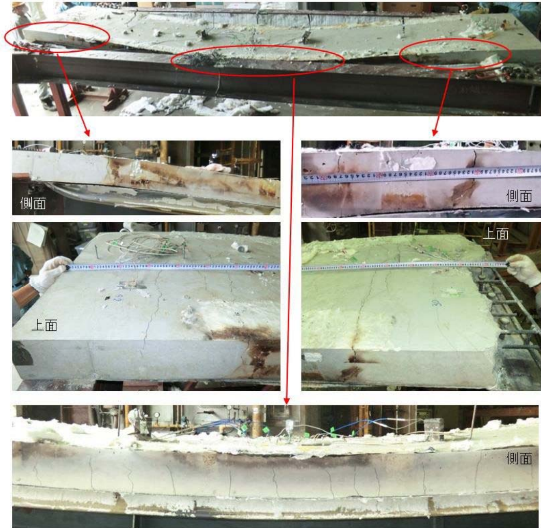
(a) たわみ状況およびスラブの亀裂状況
