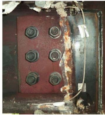
(a) 接合部の変形状況
