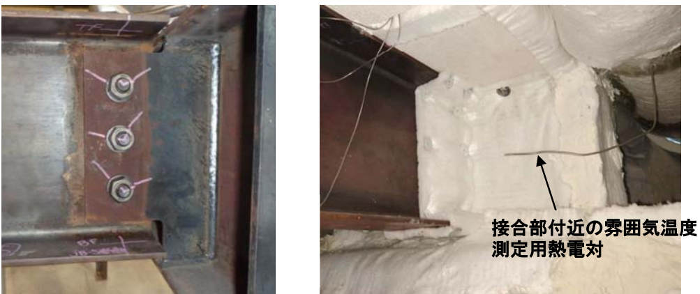
図 2.2.6 梁端ウェブ接合部の写真(左：耐火被覆前，右：耐火被覆後)
