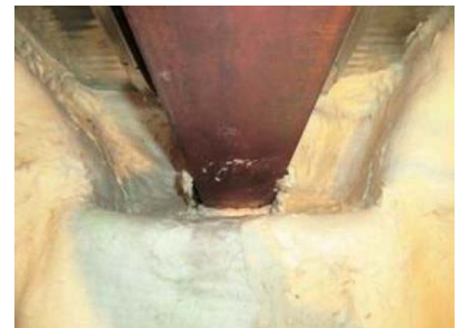
(f) ウェブ接合部付近の被覆状況 (6UP)
