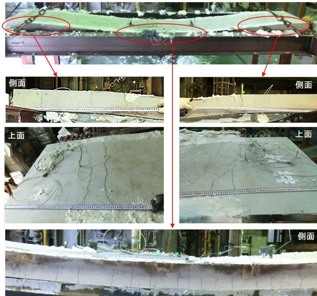
(a) たわみ状況およびスラブの亀裂状況
