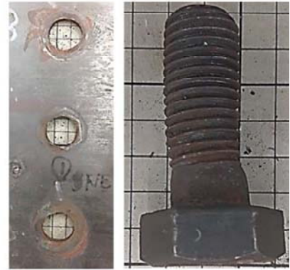
(b) ボルト孔と下段ボルトの変形状況
