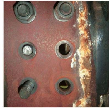
(b) ボルト孔の変形状況
