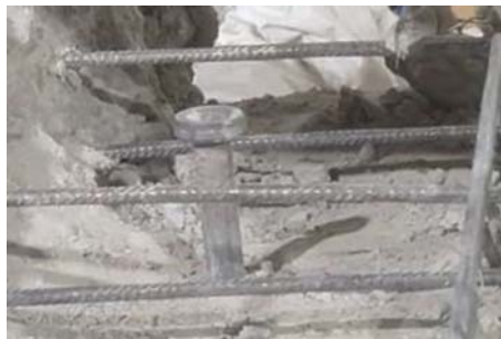
(c) 頭付きスタッドの変形状況 (梁端付近)
