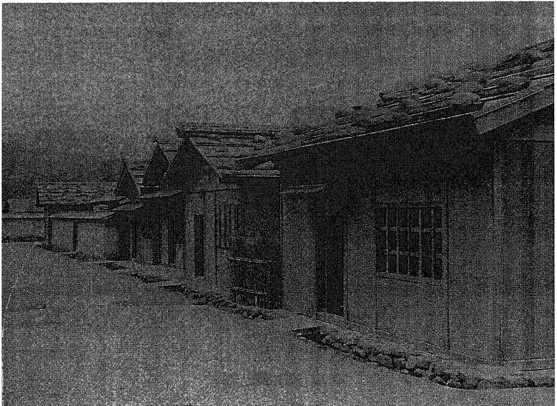
同上（南西から）
