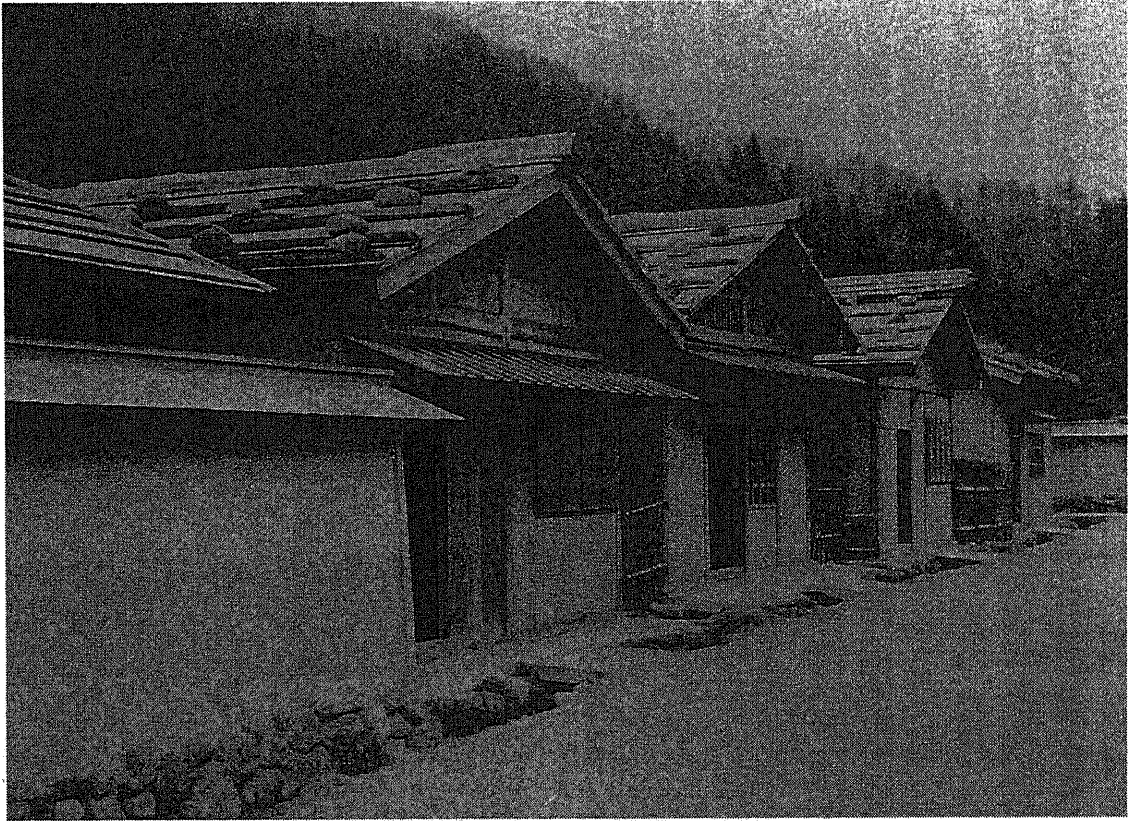
妻入町家群（北西から）
