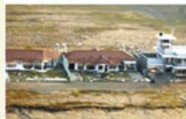
宇宙から災害レベルを診断 バングアンタラン津波（2006.7） (上) 津波に襲われた漁村、(下) 津波に破壊された民家、上の円内を拡大
