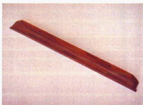
図6-16 ドア枠内側のぎんなん面に加工された額縁
