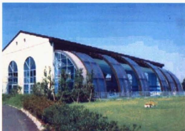
写真-1 プール建屋の可動式外壁の事例（岡山）
