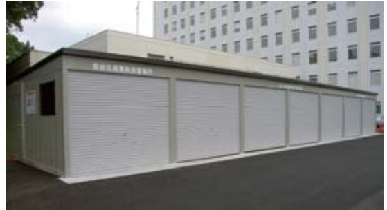
新設された廃棄物保管庫
