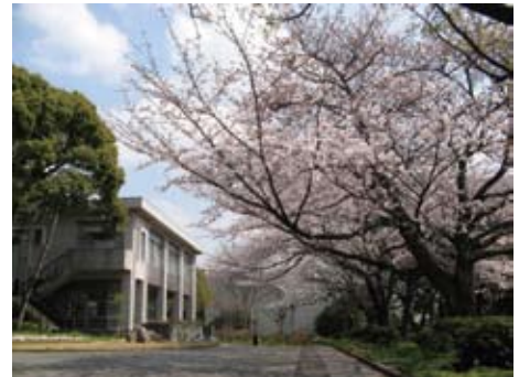
園芸学部管理棟前
