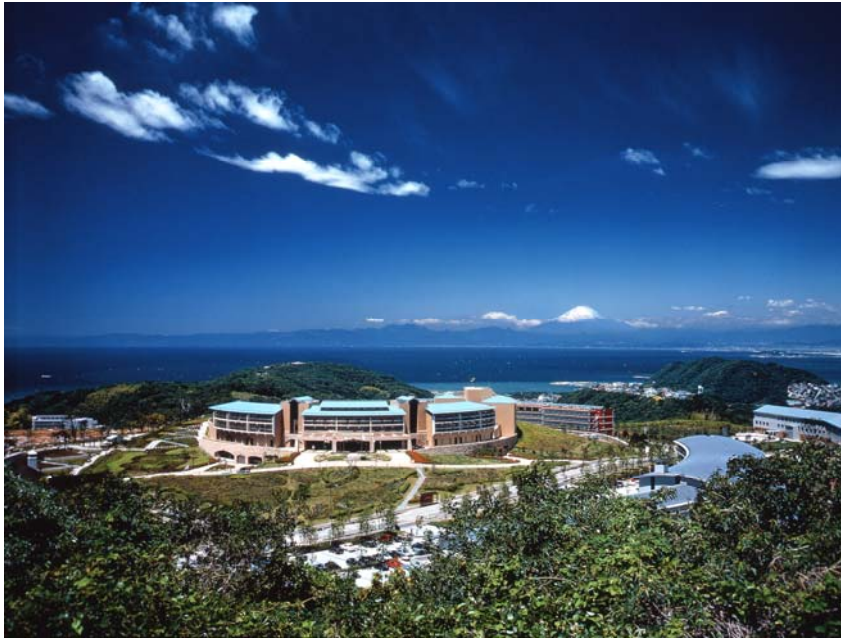
図 3-42 湘南国際村センター（道路側からの見え掛り：4F）
