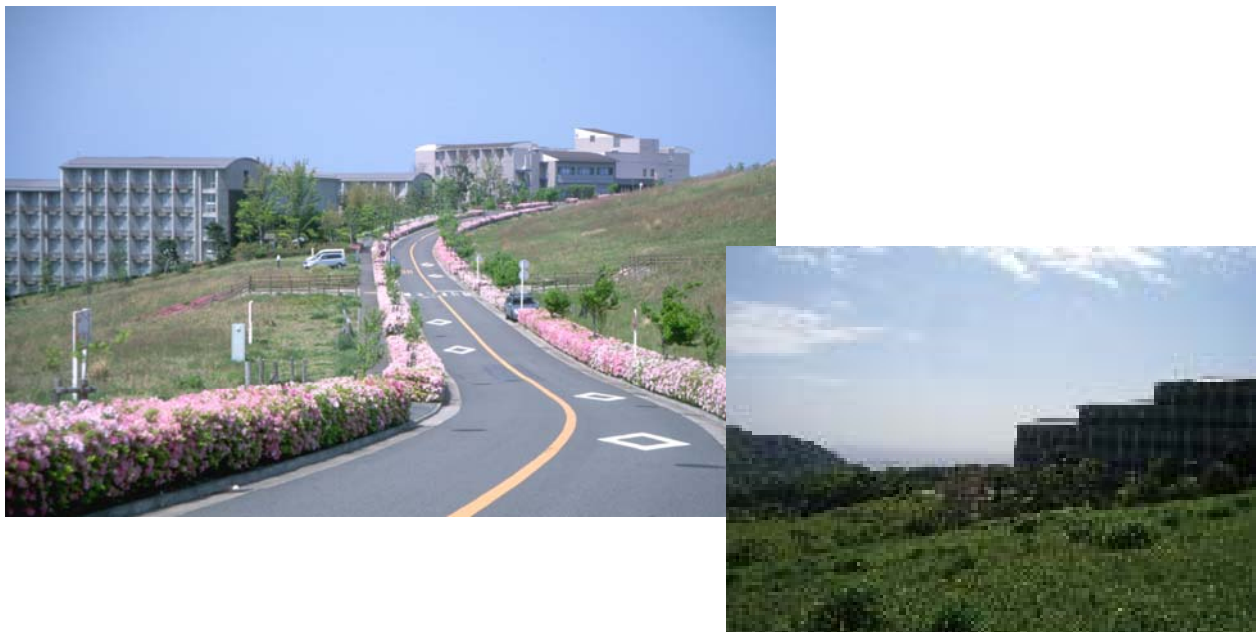
図 3-23 スロープ造成敷地
