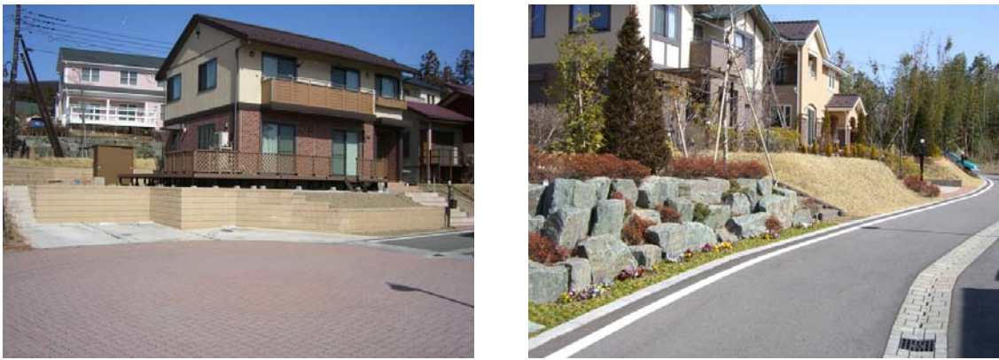
図 4-18 分譲後の宅地沿道部の改変事例
