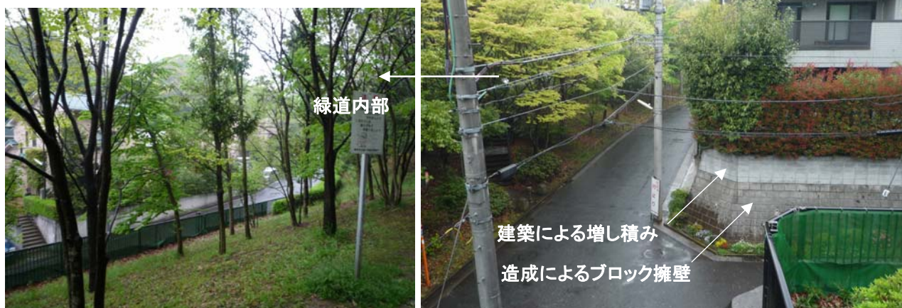
図 1-1 緑地との連続性を遮断する戸建住宅地の擁壁（港北 NT）
