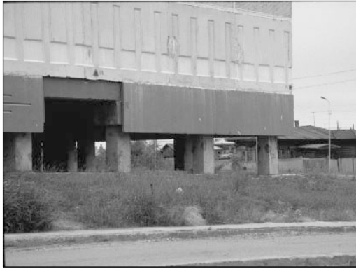
←写真3 コンクリートの高床式建造物 右に見えるのは古い木造家屋
