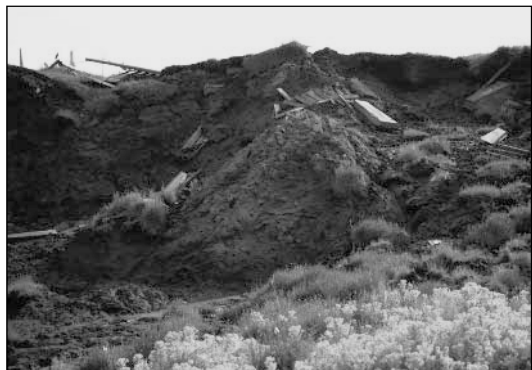
←写真9 崩壊する墓地
