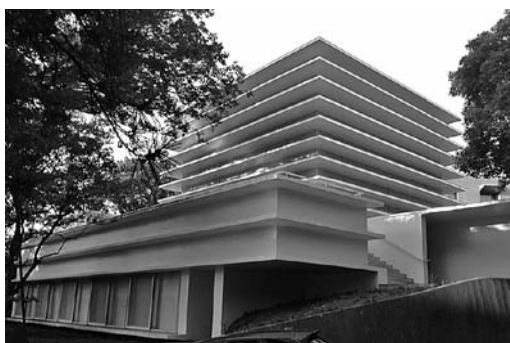
手前の談話室の上にホールがそびえる 事務室はホールの向こう側
