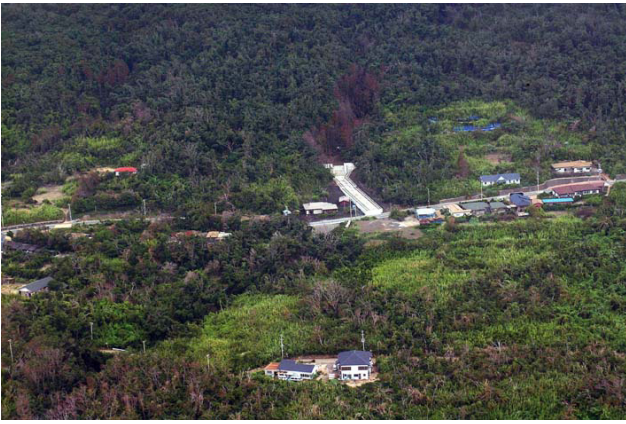
写真10. 土佐の導流堤の工事.
