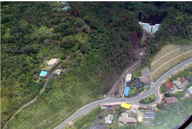
写真11. 釜の尻沢の流路改修工事.
