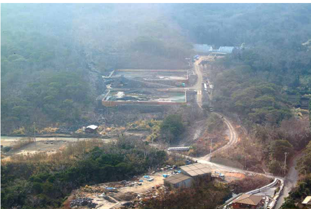
写真6 神着の貯水池、砂防ダム建設の様子。貯水池はほとんど灰、泥で埋まっている。
