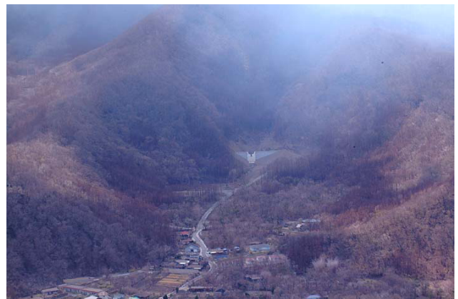
写真 9. 三池浜奥の泥流対策の工事。植生の損傷が最も著しいところ。
