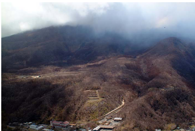
写真10. 村役場の背後の砂防工事.
