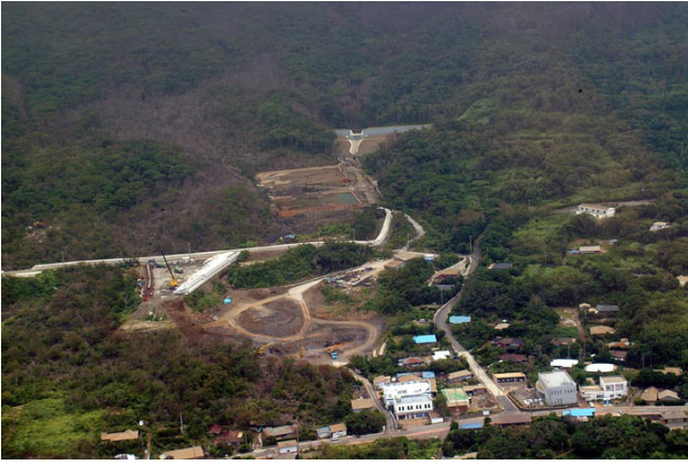
写真9. 神着, 川田沢周辺の泥流対策の工事.
