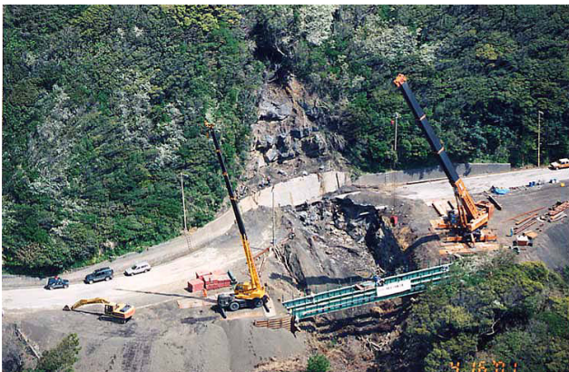
写真11. 立根の“三宅島一周都道立根橋仮橋”架設工事の様様
