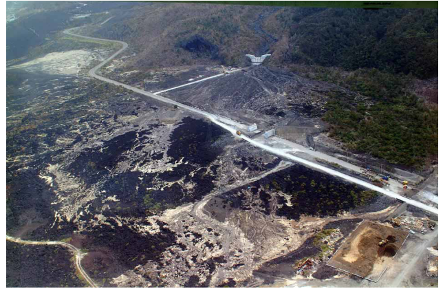
写真12. 赤場峠の砂防ダム, 都道との交差部分の流路工事.
