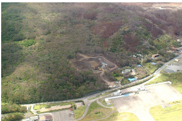
写真11. 空港ターミナルビルの工事. その山側の砂防工事も始まった. この付近は植生の変色, 枯死の多い北(右上)とそれほどでもない南(左)の境界になっている.
