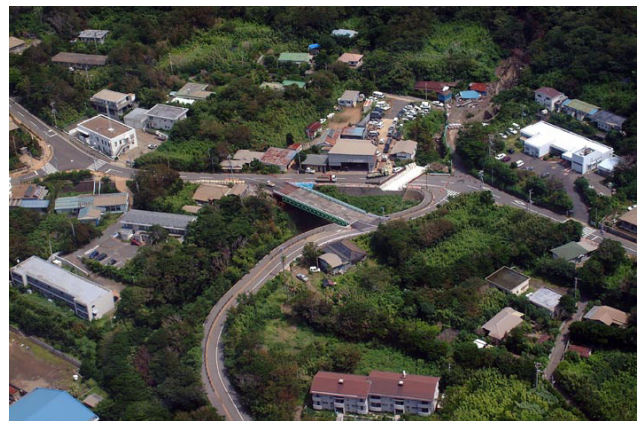
写真8. 伊豆. 都道と交差する坊田沢の流路改修工事.
