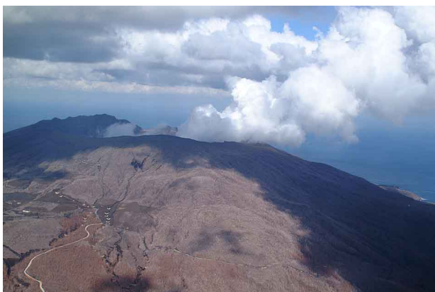
写真 11 龍根上流南山腹の砂防工事の様子。
