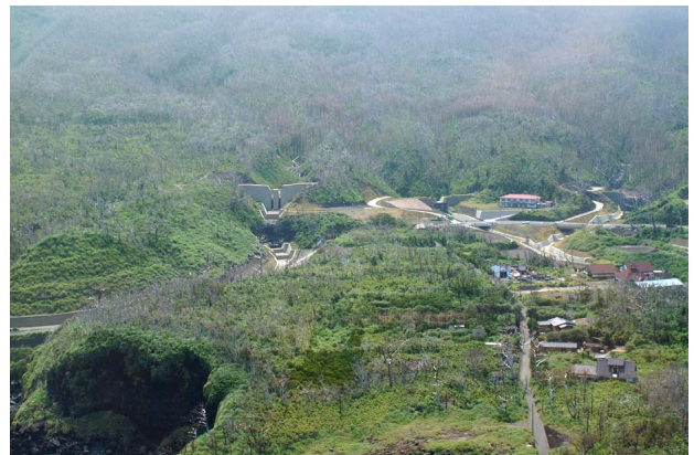
写真 3 御子敷 (三池-赤場岬 間) 付近の砂防工事の様子.
