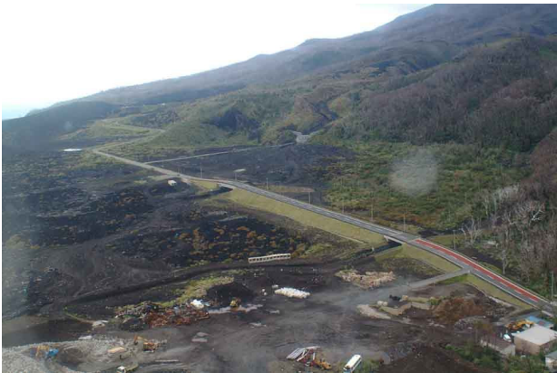
写真 6 赤場暁の, 路面が嵩上げされた都道. 下りには滑り止めの舗装 (赤) になっている. 細かい配慮.
