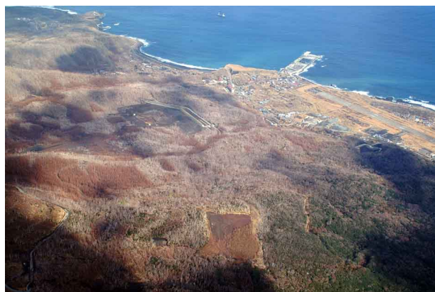
写真 12 村役場背後の砂防工事の様子。
