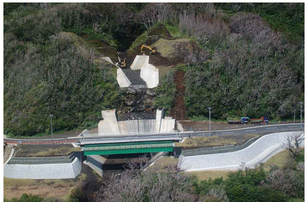
写真 8 立根にできた橋と仮橋(手前)
