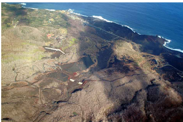
写真 10 赤場暁一地獄谷の砂防工事の様子。
