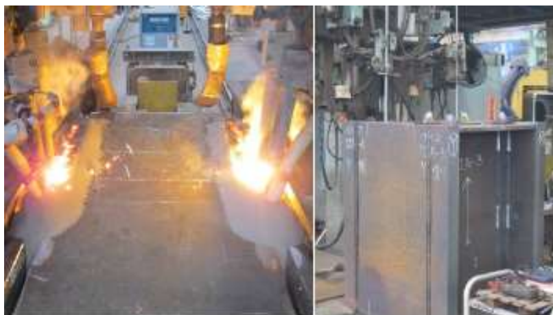
図 1.5 1 パス 2 電極 SAW 溶接と通常開先形状 ESW 溶接の施工状況 [4]
