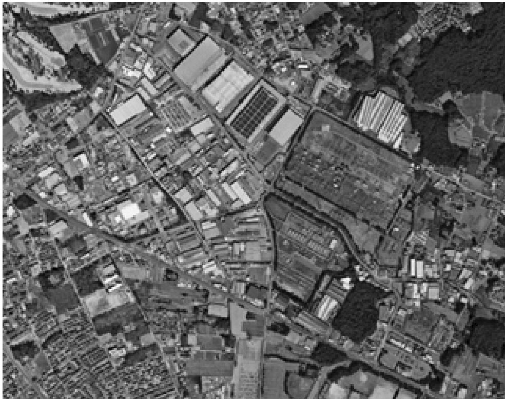
写真-8 野田南部工業団地全景
