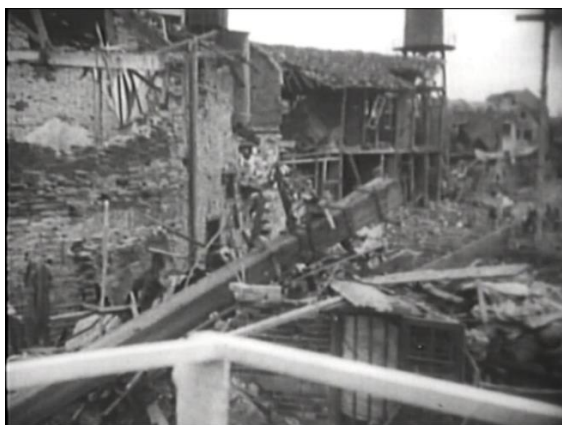
図7 『上海』破壊された市街地
