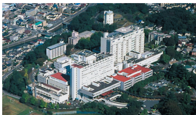
2008年(平成20年)附属病院新病棟竣工
