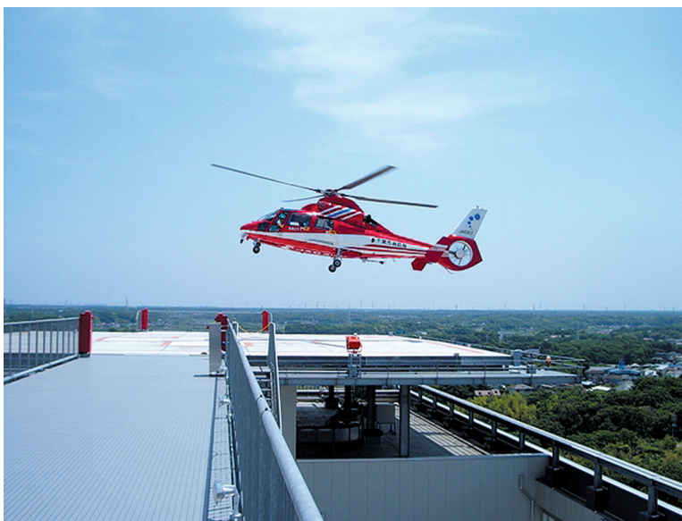
ひがし棟屋上ヘリポート
