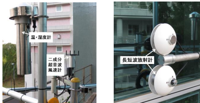
写真 4.3 2階バルコニー一部の計測器設置状況
