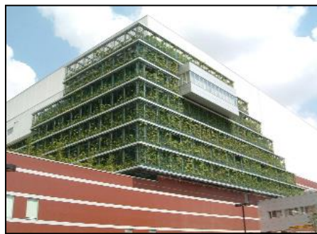
タイプⅣ プランター+支持材型 (板橋清掃工場)
