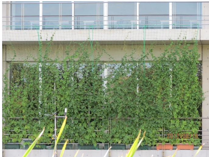
写真 4.10 大学構内に設置したグリーンカーテンの生育状況
