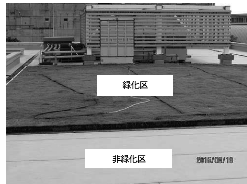
写真1 屋上緑化基盤の敷設状況
