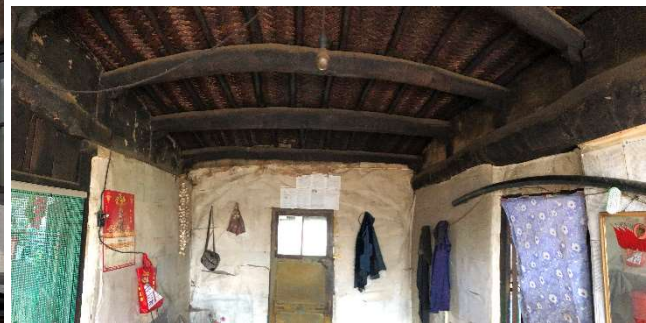
図 前門から撮影した外屋の様子
