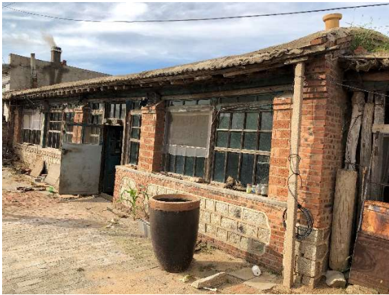
図 母屋（右側の柱状のものは臨時的な支え）
