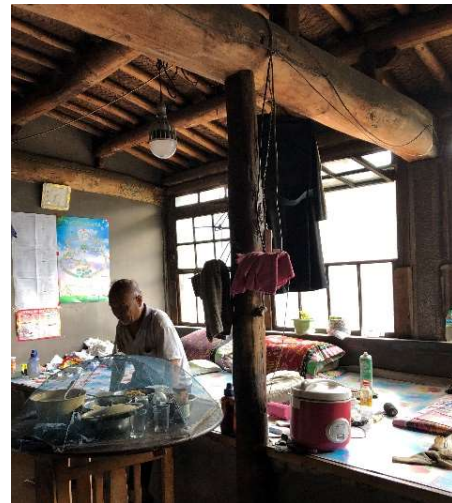
図 梁と抱沿柱との構造
