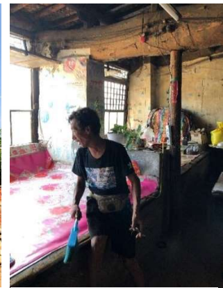
図 炕（梁と抱沿柱とを基礎にした、部分的な仕切りが残った）
