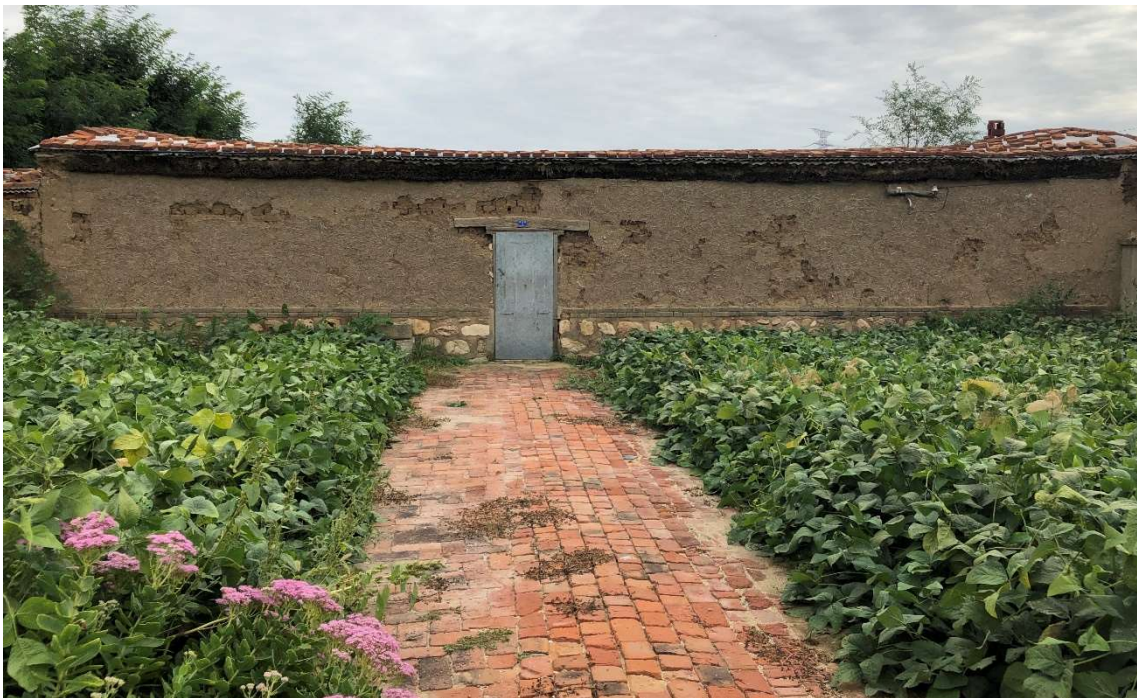
図 母屋の裏面（干し煉瓦でつくられた北壁）と後園子（大豆が栽培されている）
