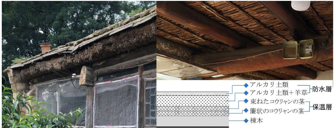
図 1-19 秸秆薄(外見+内部+断面見取り図)
