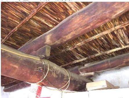
図 屋根の骨組み（コウリヤン茎でつくった保温層）
