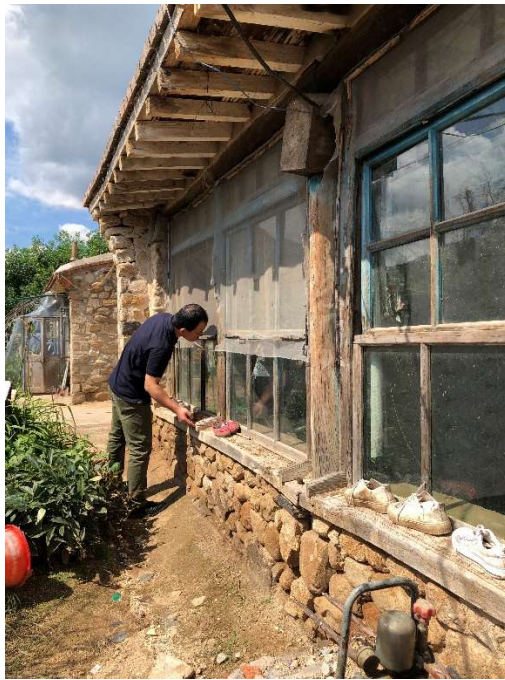
図 母屋の一部（西屋側）
