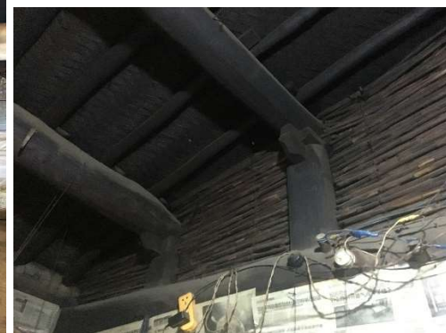
図 梁と棟木との間にコウリヤン茎が使われた
