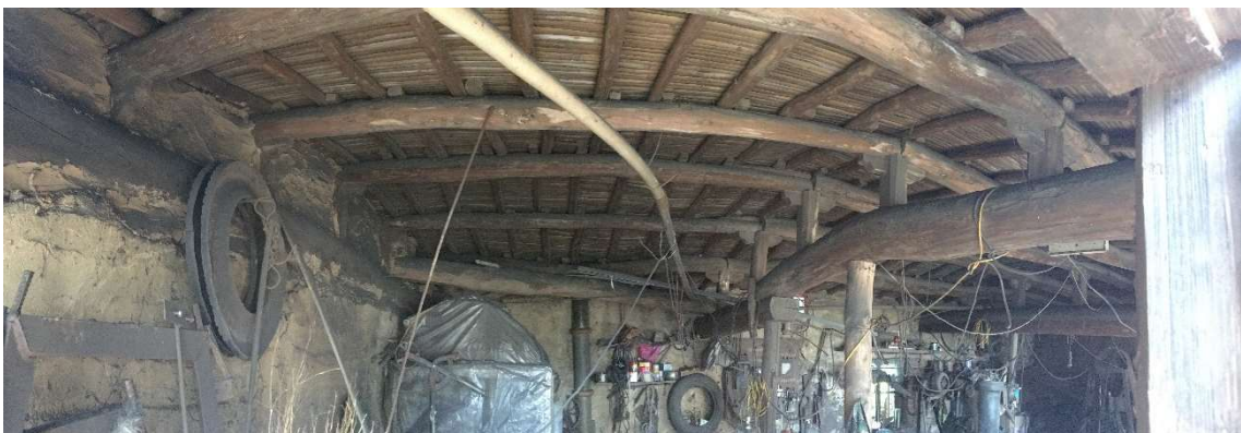
図 屋内の天井の木構造（パノラマ写真なので、歪んでいる；壁にいろいろな部品をかけている）
