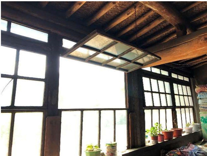
図 西屋の窓側の様子
