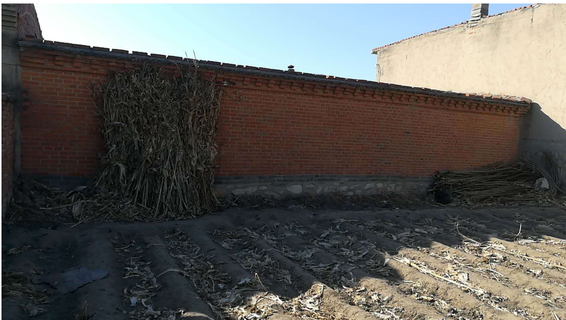
図 平房の裏面（もともとは青煉瓦であったが、90年代初頭に赤煉瓦で改修した； 冬期には玉蜀黍の茎を後門に立てかけて保温している）
