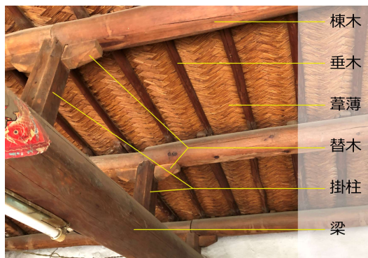
図 2-14 梁と棟木を繋ぐ構造
