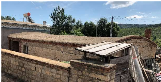
図 裏側（塀で遮られている）
