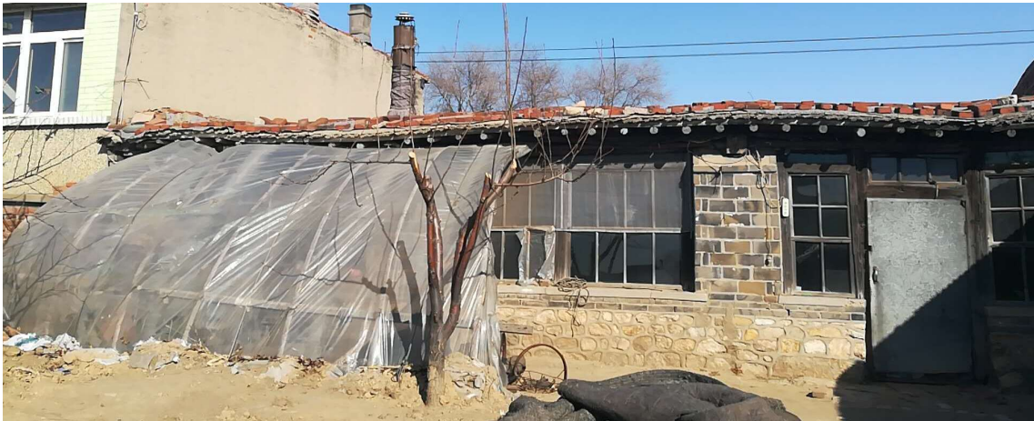
図 平房の正面（西屋の一部分は保温のためにビニール素材のカバーがかけられている）
