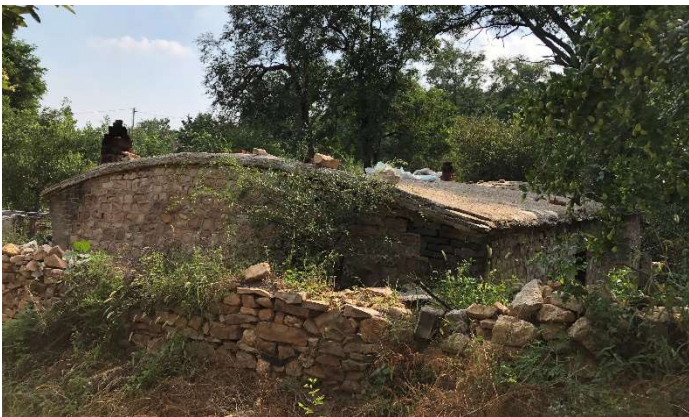
図 北側から見た母屋の裏側の様子
