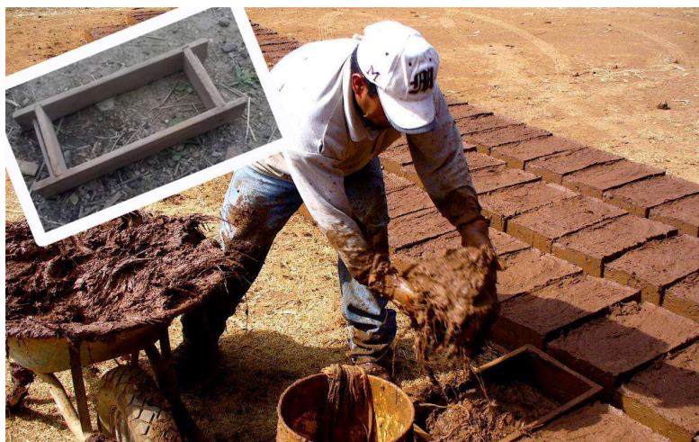
図 2-21 干し煉瓦づくりと木製の干し煉瓦型
