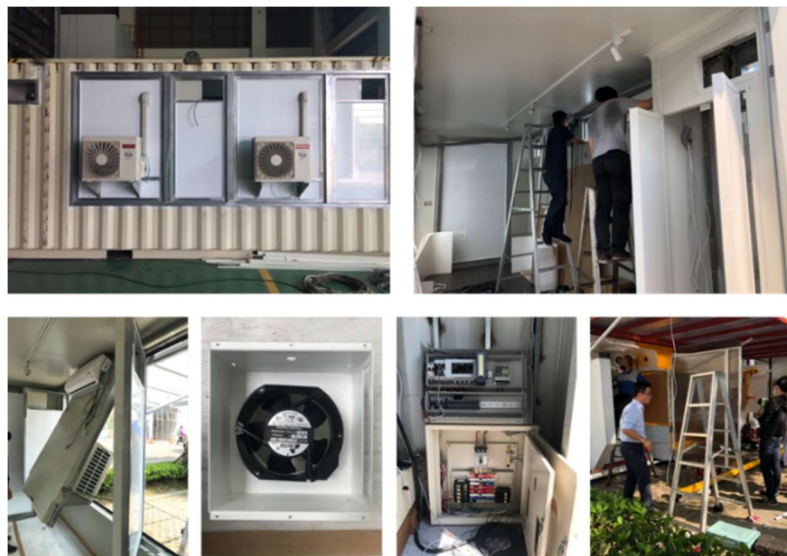
圖 4-3-17：設備工事中風景
