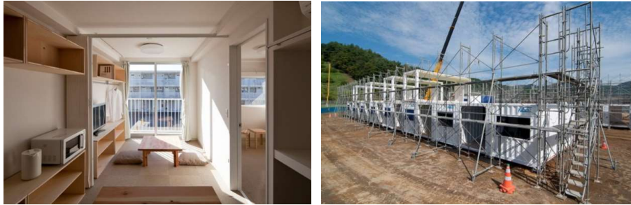
図 1-4-7 : Container Temporary Housing 出典：小島設計
