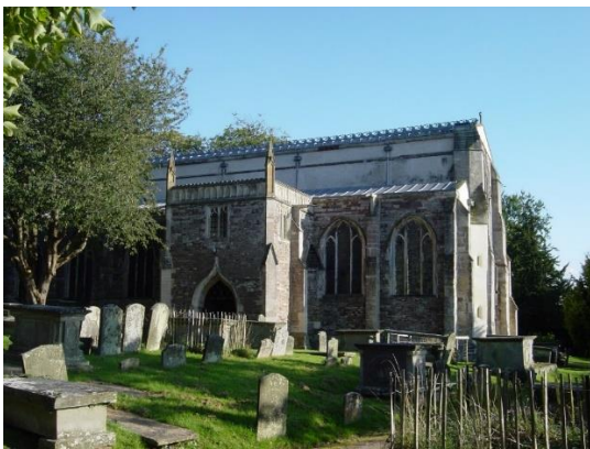
セント・メアリー教会、主祭壇左手の床にジェンナー家の墓がある
