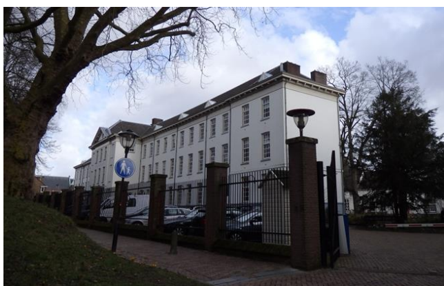
旧ウトレヒト陸軍医学校の建物
