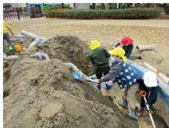
図13：協同で「工事」をする様子4
