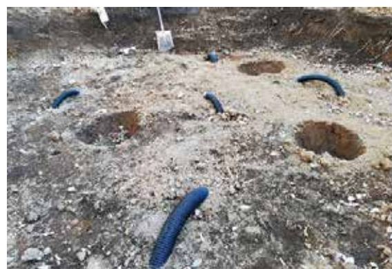
図15：透水管を埋める
