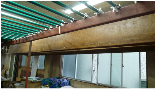
図 4-4. 長板 天井から吊り下げた棚に収納している。
