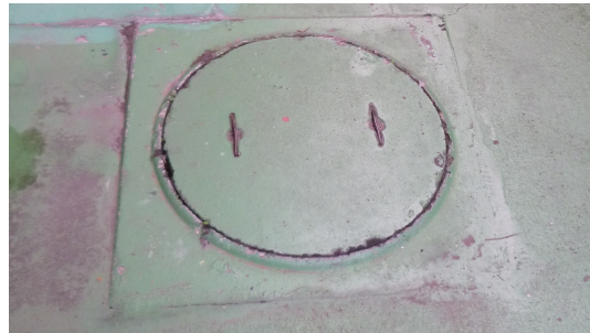
図 4-23. 120mの井戸。 地下からモーターで水を汲み上げる
