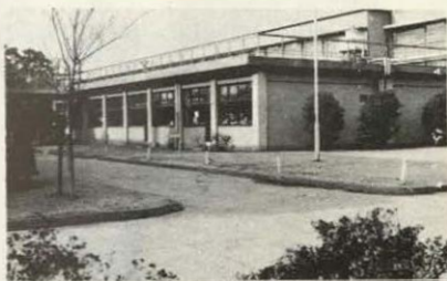
▲ 園芸学部分館
