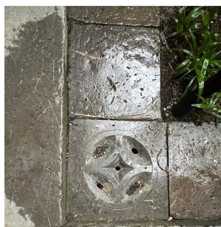
図 2-17 天井の排水口
