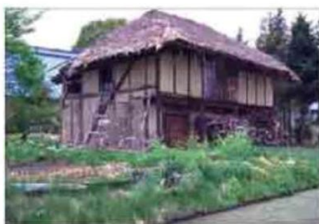
屋根材がワラの例
