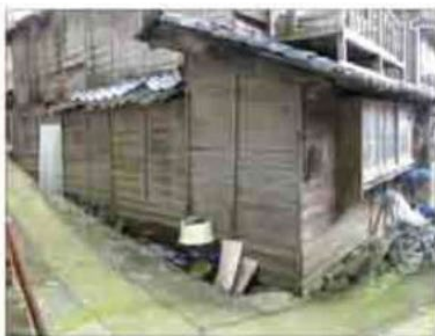
外壁が裸木造の例
